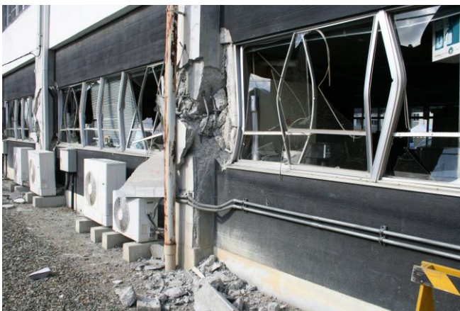
2011. 3. 12 地震により全壊した市役所本庁舎
