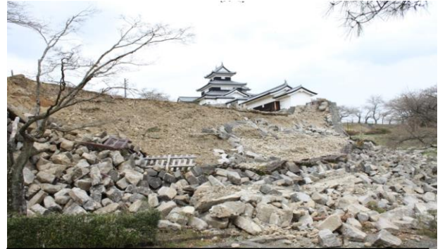
地震により崩落した白河子峰城の石垣 (平成 23 年 3 月 11 日 白河市)
