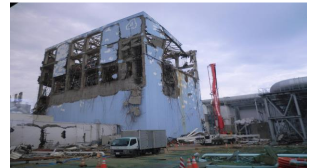
水素爆発と火災により破損した福島第一原発 4 号機 (平成 23 年 5 月 1 日 大熊町)
