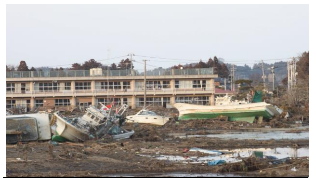
津波の被害を受けた真野小学校 (平成 23 年 3 月 13 日 南相馬市鹿島区)
