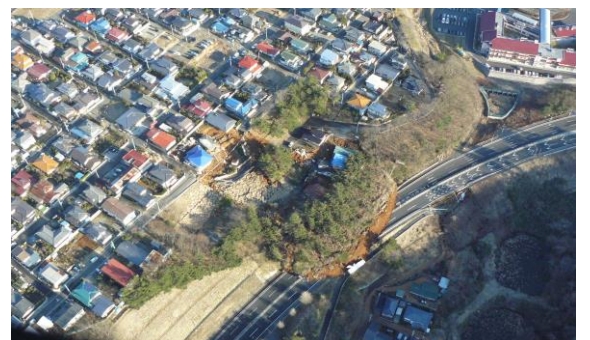
土砂崩れにより通行止めとなった国道 4 号線 (平成 23 年 3 月 11 日 福島市伏拝)
